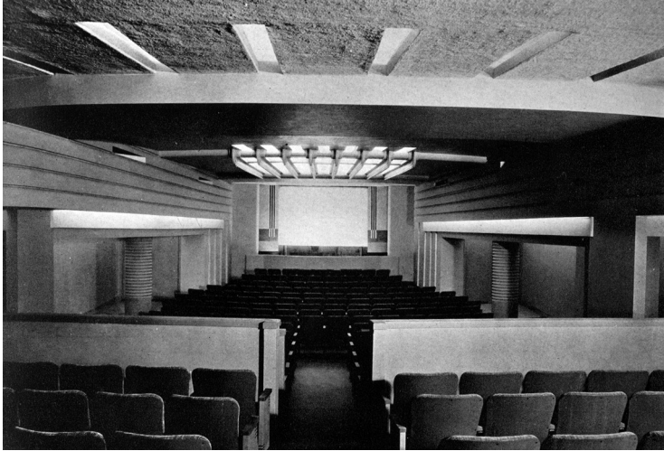
2 Das Thalia Theatre besaß einen gegenläufig geneigten Boden («reverse-sloped floor») und einen tiefer liegenden Kasch (The Architectural Forum, September 1932)
